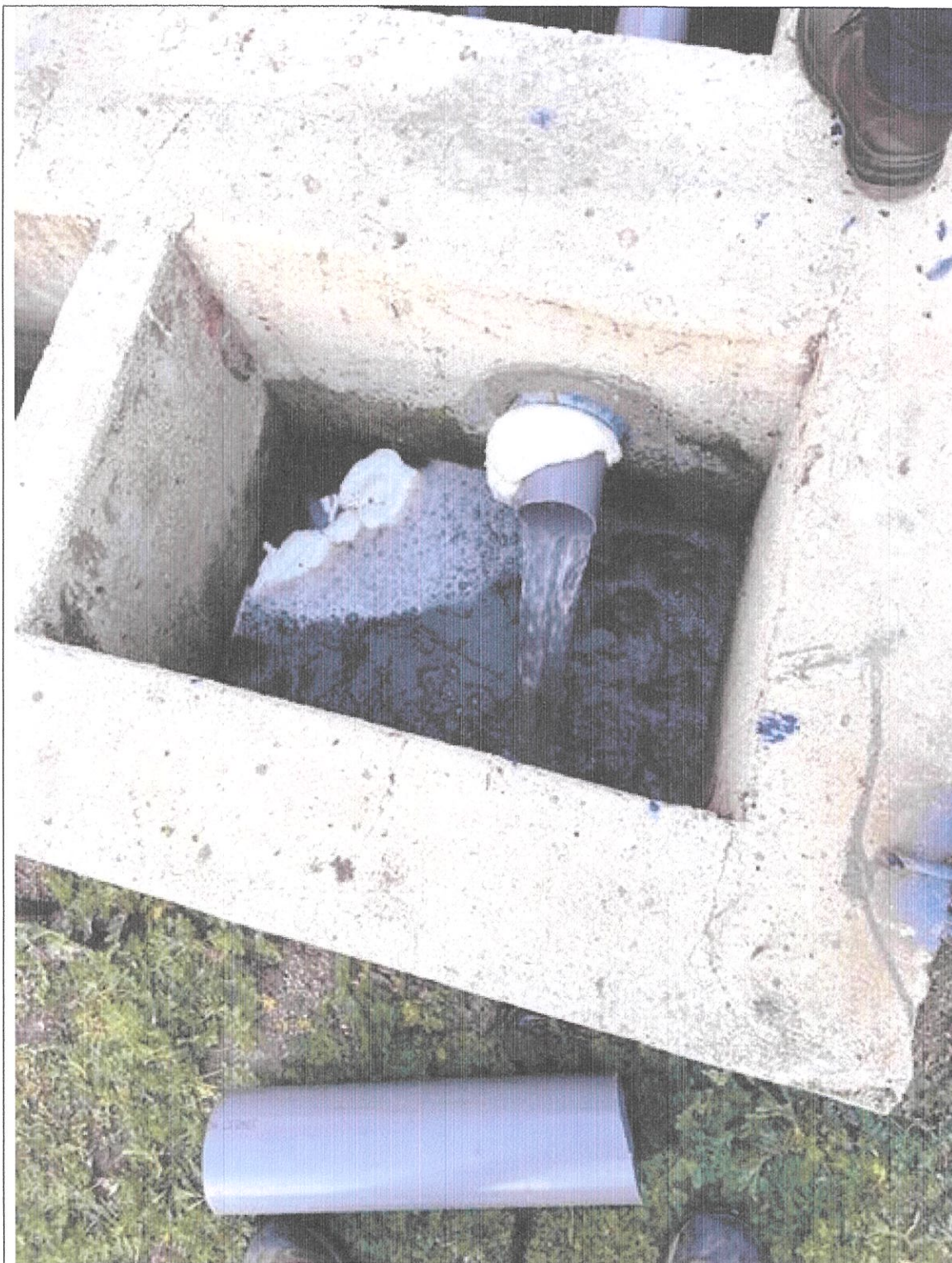
Ilustración 14: "Agua tratada con sistema provisorio en Escuela Quelentaro"
