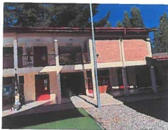
El cual consiste en el cambio de las canaletas, cubre alero y tapacanes. Se plantea utilizar terciado ranurado para cubrir los aleros, instalación de pino cepillado por los tapacenes y posteriormente la instalación de nuevas canaletas.
