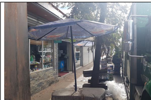
Fotografía N°5, de 19 de mayo de 2021: Vista lateral del costado sur de la edificación emplazada en calle Hermanos Carrera N°661, visualizándose el acceso desde el 1° nivel al supermercado.
