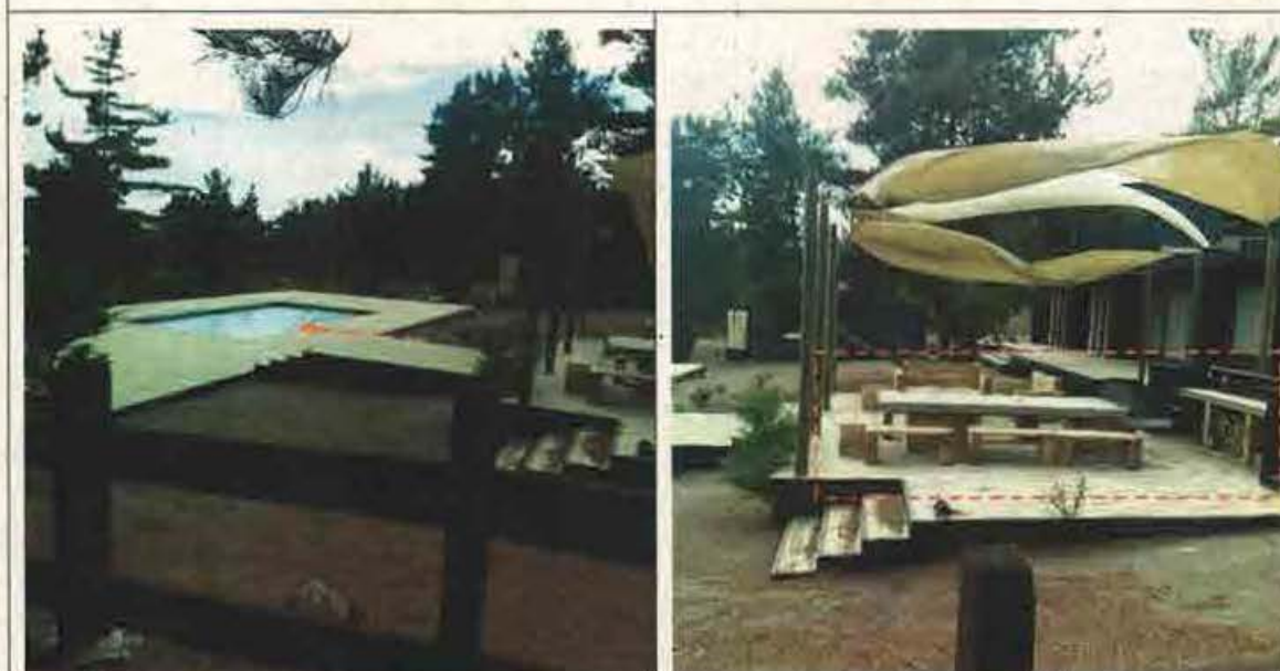
Fotografías N° 7 y 8- 11/4/2018: Construcción ejecutada en razón del Permiso de Edificación N°14, de 2017, en uso, sin encontrarse recepcionada por la Dirección de Obras Municipal de la comuna de Litueche.
