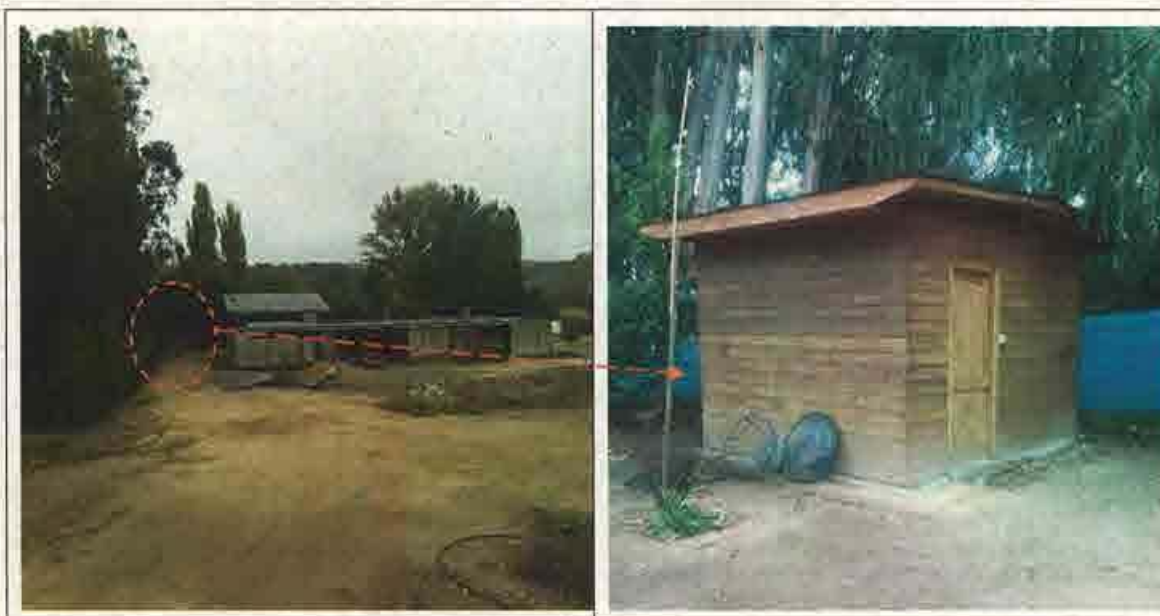
Fotografías N° 1 y 2- 10/4/2018: Volumen construido a un costado de la edificación principal que no se encuentra consignado en los antecedentes presentados para el Permiso de Edificación N°24, de 2017.
