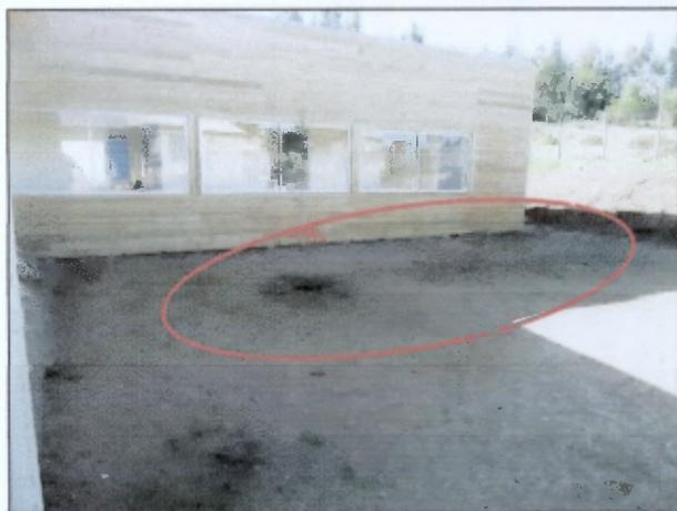
Foto N° 13: Vista del patio trasero y los restos de humedad presentes en el terreno natural, condición que ha generado la pérdida de compactación de dicho terreno y su inutilización.
