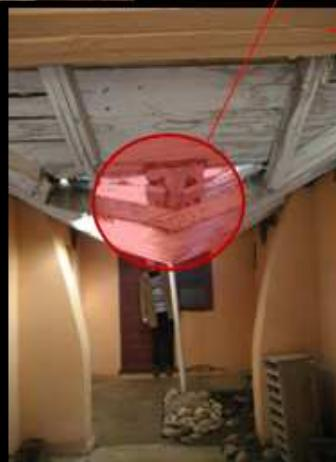
Centro de luz, Lucerna dañada por el terremoto. Su estructura de madera y policarbonatos deteriorados.
