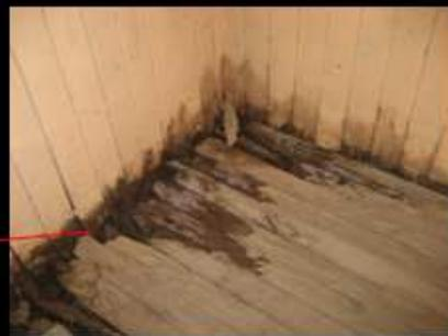
Suelos hundidos, estructura sin cimientos. Estructura en condiciones de demolición..
