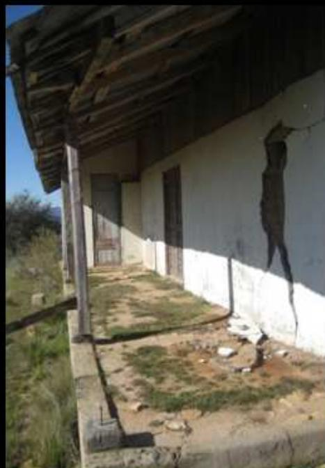
Pilares y vigas completamente destrozados. Muros con pequeños detalles a reparar
