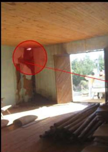
Muro con quiebre estructural, necesita restructuración reforzada
