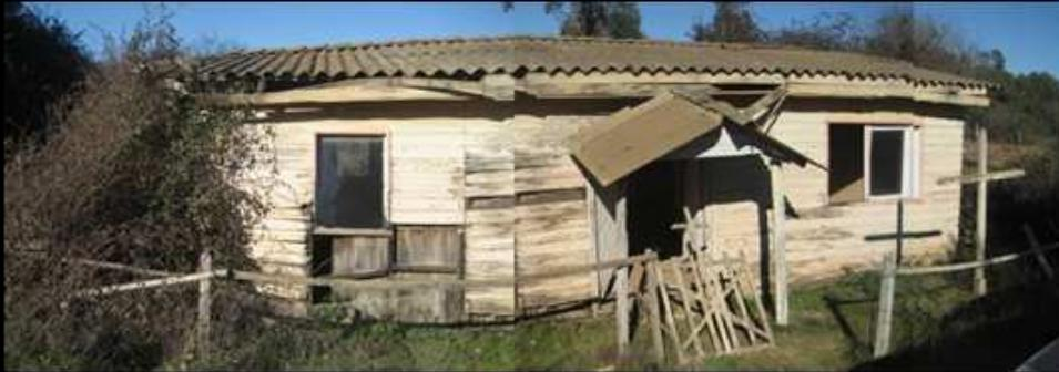
Fachada de madera completamente destruida. Maderas corroidas.
